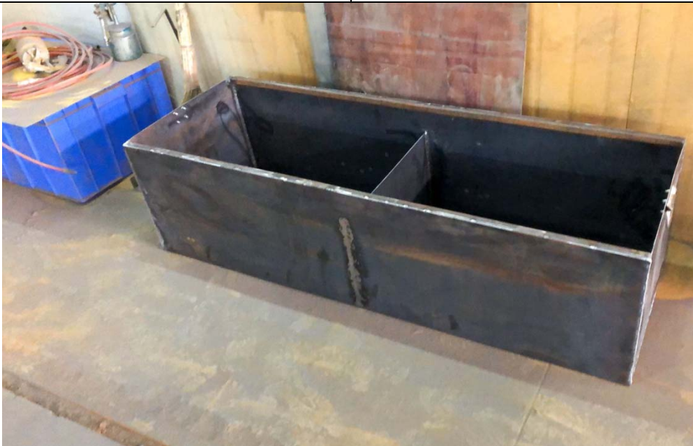
水性漆喷枪工作台及喷漆清洗废水收集循环池
